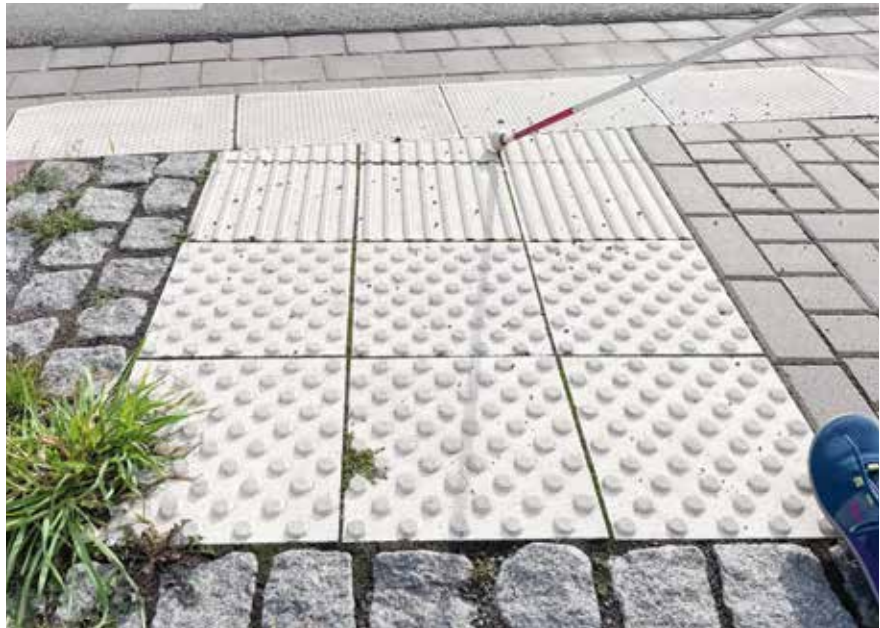
Blindenteknik an Ampeln (Foto linke Seite) und spezielle Bodenplatten helfen Menschen mit Sehbeeinträchtigung, sich zu orientieren.
